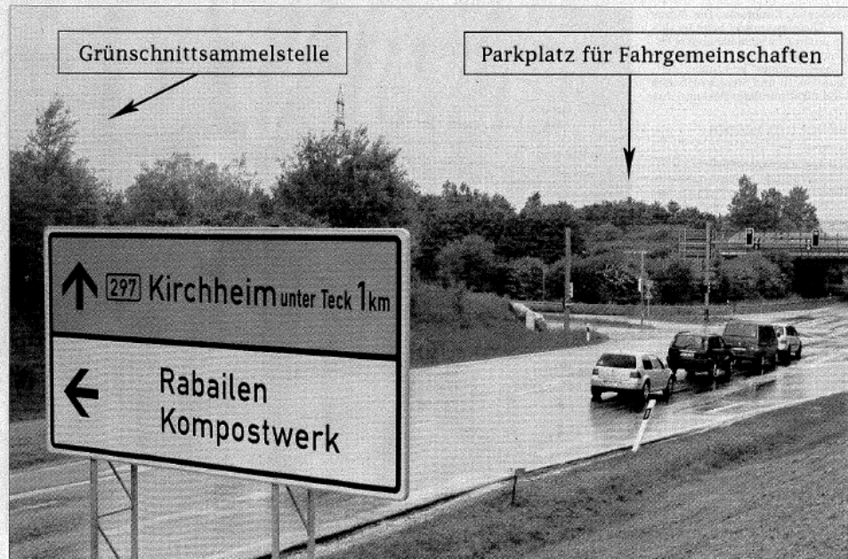
Blick auf die Auffahrt Kirchheim-West südlich der Autobahn. Wer links Richtung Rabailen abbiegt, wird eines Tages nicht nur zum Kompostwerk gelangen, sondern auch zum Recyclinghof und zum „P und M“-Parkplatz für Pendler. Foto: Jean-Luc Jacques
